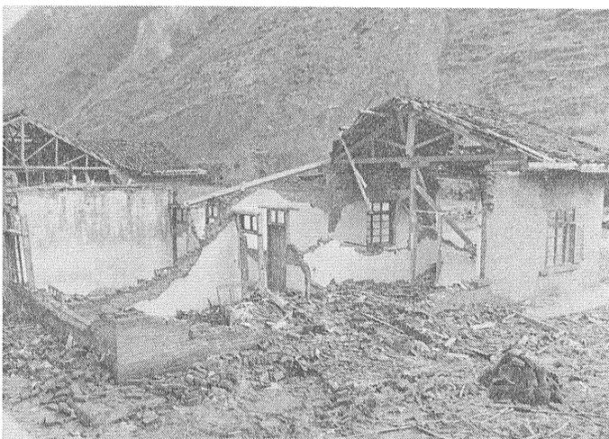
写真8 松潘平武地震被害 病院の崩壊(松潘県)
