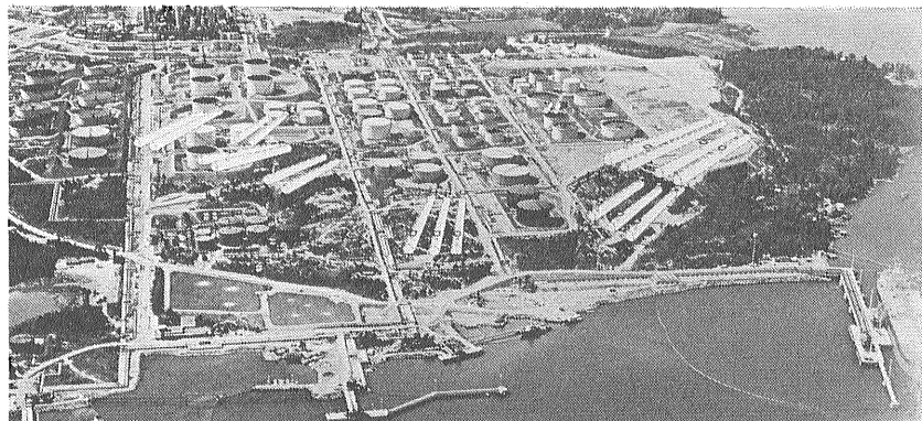
第15図 フィンランド最大の石油地下備蓄基地 ボルボ 貯油トンネル（キャバーン）は既 存の陸上石油タンク地域の下部の岩盤下 に作られている（白抜き点線の部分）
