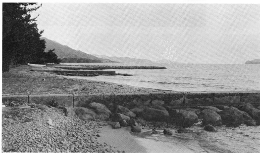
写真11 天の橋立から湾口方向を望む（1978年9月） 防波（砂）堤は 波浪流による砂の移動速度を遅らせつつある
