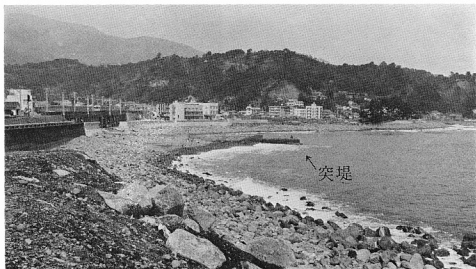
写真6 “陸地”から運搬されて来た土砂により突堤手前に形成された砂浜
