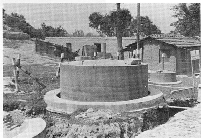
写真11 カトマンズ最大の 水溶性ガス用タンク
