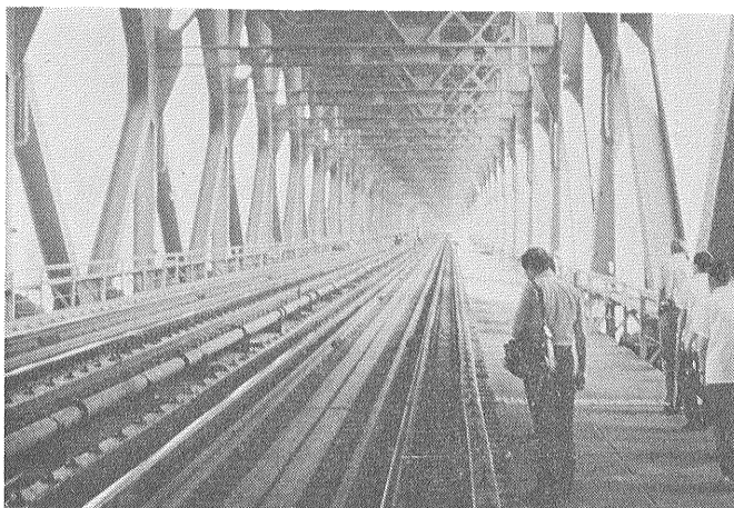
写真18 南京大橋の鉄橋
