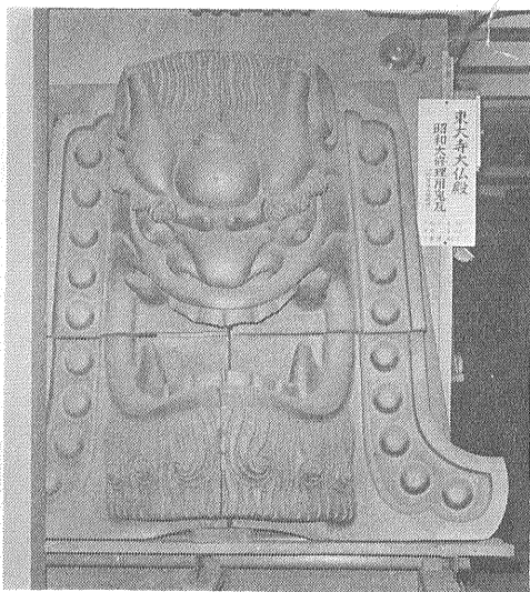
写真4 東大寺大仏殿昭和の大修理用鬼瓦(奈良市瓦宇工業所製作) 高さ1.3m 幅1.65m 重量 450kg
