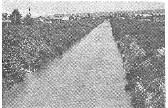
写真2 低地帯中央を流れる中央排水路
