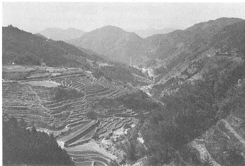
写真4 高知県中部における蛇紋岩地帯の地すべり地形 50年 51年災害時においては著しい変動は認められなかった
