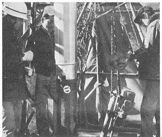
写真3 スクリーン降下作業
