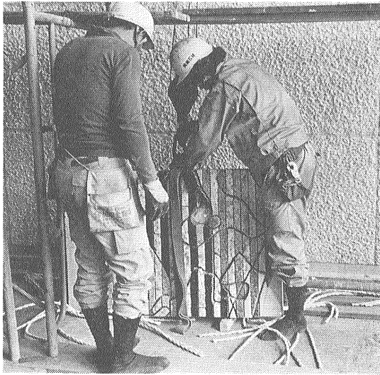
図 6 岩石モザイク張り 作業中の1部 北海道亀田半島および青森県下北半島のレリーフが見られる 陸域は海域に比してやや凸出している（80m/m）モザイクの部分は1,200m/m×800m/mのトラバーチン板上に接着剤で張りつけられる。トラバーチン板の壁面固定は岩石張りつけによる重量増のため1枚につき2か所程度壁面コンクリートに埋め込んだボルトでとめられる。ボルト部分には構造区分にあわせた岩石片がはめこまれる
