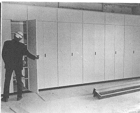
図 15-2 床置型収納棚 当初各研究部の部長室として設計された室に標準的に装備されている収納棚で 壁面全面を利用して6台設置されている
