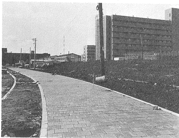
図 28 工業技術院B地区正面入口から中心部に向う歩道 歩道の両側には植栽が行われる 右手8階建の建物が地質調査所の研究 本館 その奥6階建の建物は微生物工業技術研究所の研究本館 地 質研究本館の手前 パイプで枠組をしてある部分は1階天井まで工事 が進行中の海洋実験棟と実験地学研究棟 左手正面は共用中央本館
