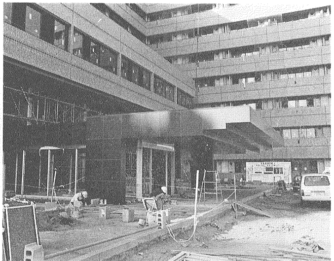
図4 建設中の正面玄関
