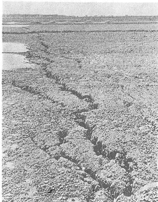
第3図 邢台郊外に生じた地割れ
