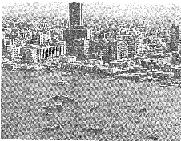
写真1 高層ビルが目立ちはじめた最近のジェッダ市 大変な建築ブームである。
