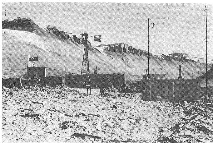
図22 Vanda (バンダ) 基地風景 (1968年設置)。 風車発電が使われている。
