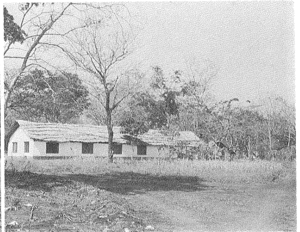
第6図 バクワマウラン鉱床開発基地の住宅 住宅としては立派に見えるが 無人の故か 内部は崩れ落ちていた
