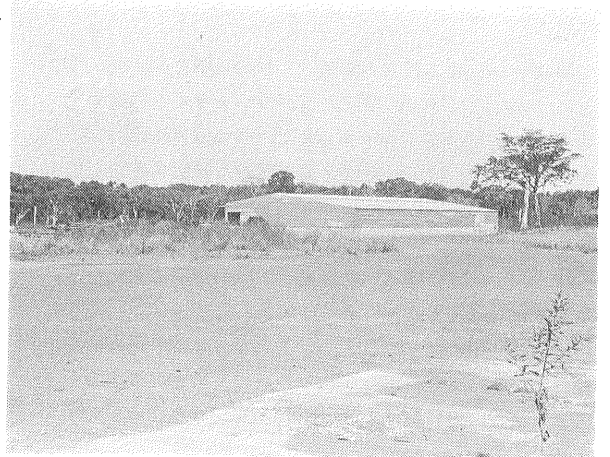
第2図 バクウマウラン鉱床の開発基地 密林を切り開いた広大な敷地にはこのような大きな家が建っているが まったく物音がしないだけに一しおわびしいたたずまいである
