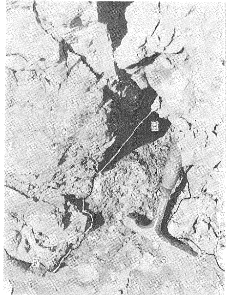
写真4 衝上断層にそって開口した地下水の通路となった空洞
