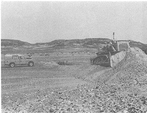
写真⑩ Khashim Radi にて 粘土層の延長を追ってトレンチを掘るブルドーザー
