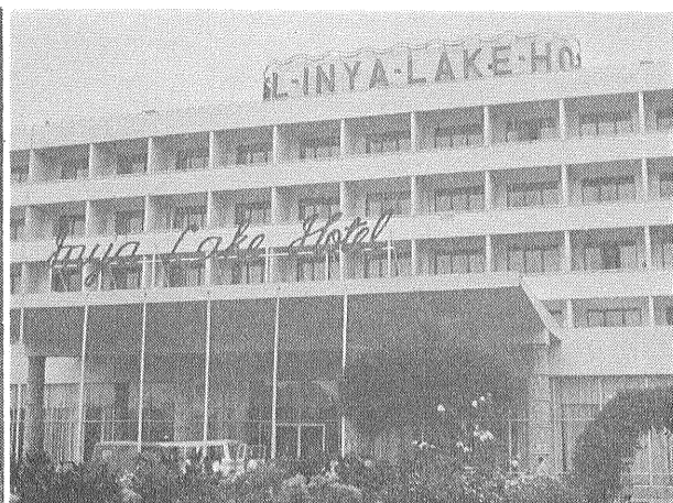
第3図 インヤレイクホテルの正面(ラングーン) ソ連が供与したビルマ最高の外国人用ホテル インヤ湖畔の広々とした地に立っている
