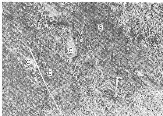
図版14 楠神層の衝上に伴う破碎帯 S:破碎された黒色粘板岩(波川層), C:チャートの角礫 図版13の断層から南15-20m付近の波川層には厚さ1-2m 長さ1-3mの緑色千枚岩やチャートの巨大礫が取込まれ さらに25m南の図版14には破碎された黒色粘板岩(黒色部)にチャートの角礫(20数cm以下)が入っている。断層からこの付近まで厚さ約30mが広義の断層破碎帯である(筋川南部)
