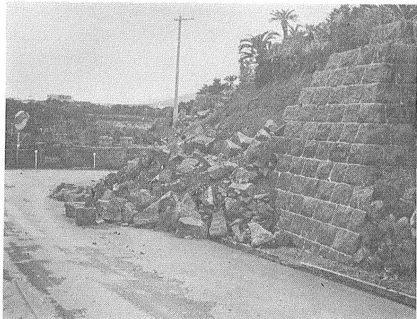
写真① 石垣の崩壊。三根から登竜峠へ至る道路際 (1972年12月15日撮影)。
