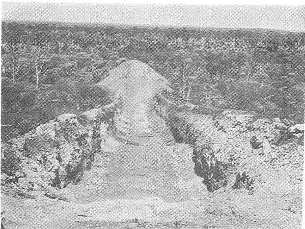
写真⑥ 太古代の岩石中に胚胎するニッケル鉱床探査のためブルドーザーでトレンチされた現場 (Scetia 付近)
