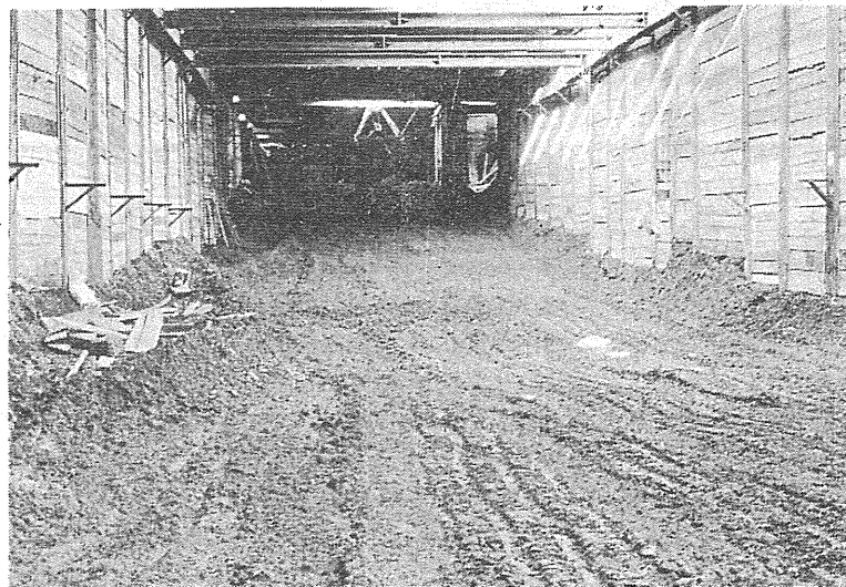
写真1 地下鉄道型式をとる掘さく工事現場の景
