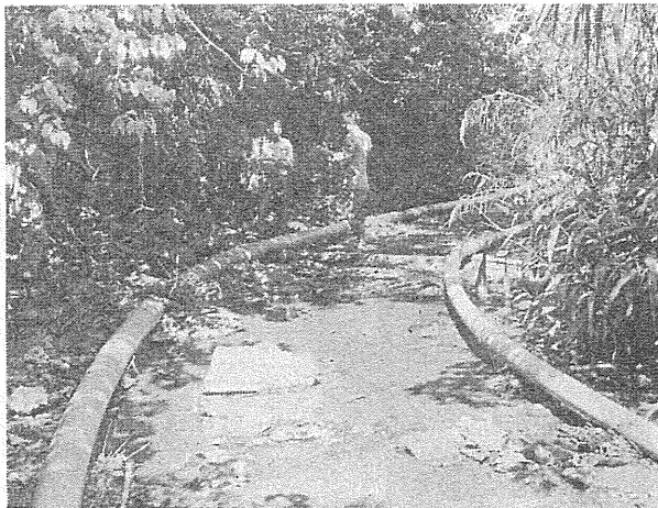
写真⑨ オリオンビール(株)と名護市上水道の幸地川水源の送水管 上流の取水口まで両者縦って延々とパイプを川床にのぼしている ふだんは川水
