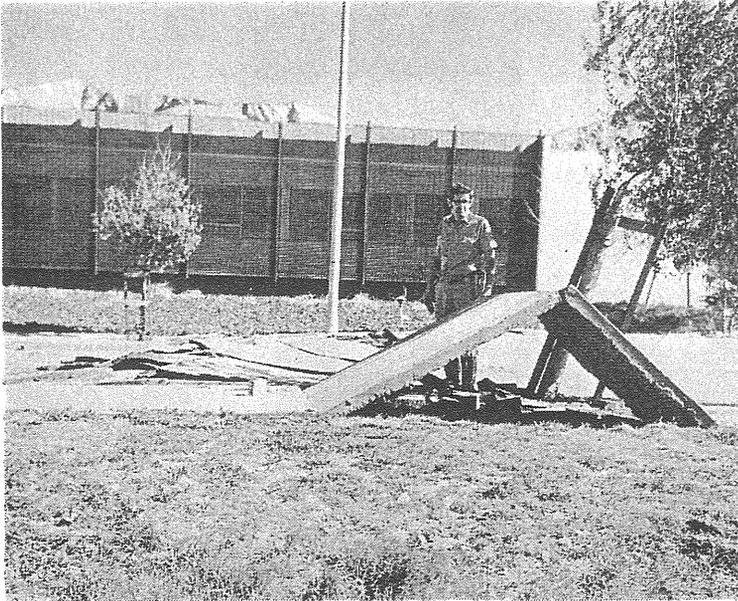
断層の末端部において 地面の圧縮により持ち上げられた舗装面
