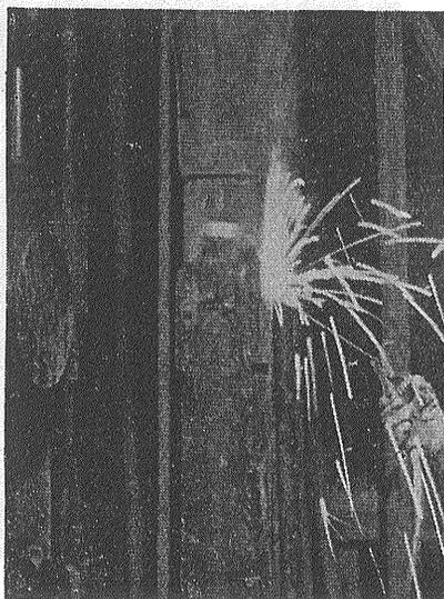
中間産出試験の準備 7" CPの溶接作業 内ソケットでネジ止めしてあるが 念のため鉄片を外側にも溶接している 上にバスケットの下部が見える
