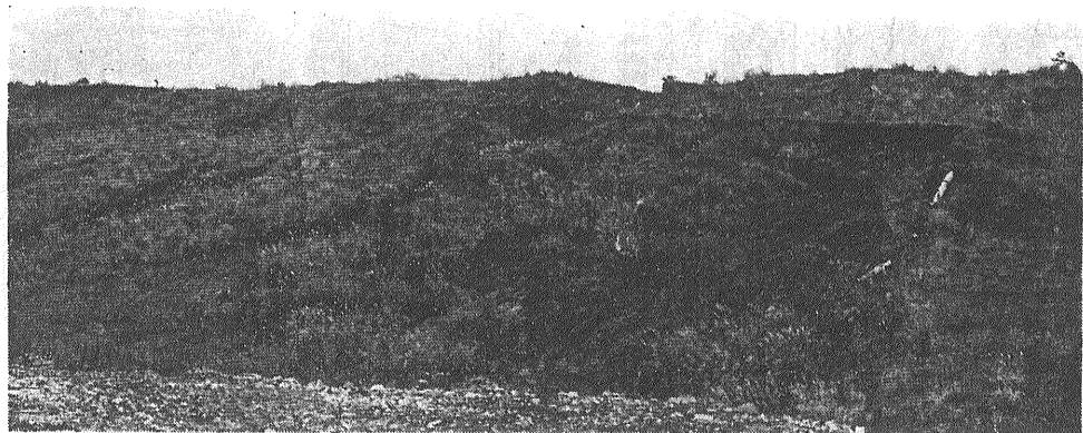
第6図 川崎市生田浄水場で幅100 m以上にわたって発生した表流水によるくずれ。ローム層はT 2 の中の土橋ロームで斜面の一部にはMロームがある。上部は切取った平坦面で、平坦な面上の排水不完全と見られる。
