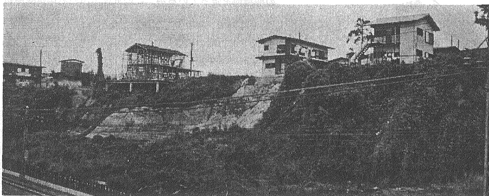
第16図 川崎市五反田川流域 生田の崖くずれで中央部のコンクリートで斜面をおおっている部分が旧崩壊地 手前は小田急線 崖下を五反田川が流れ、川の側方侵食によって崩壊したということで現在の川は路線に沿って流れている 最も危険な崖の一つ
