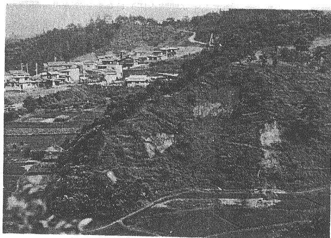
第7図 川崎市読売ランド裏の斜面のくずれで、基盤岩は第三紀の泥岩。道を造り、樹木を切ったため、道の上・下でくずれが発生している。
