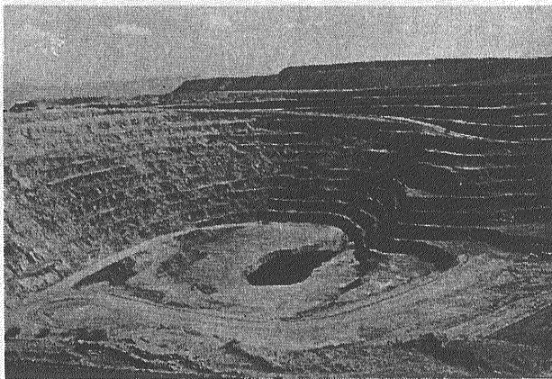
⑭ 隣接するミッション・ピット全景。こちらは24,000t/日(0.7% Cu)処理である
