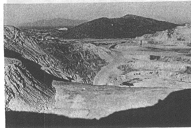
⑮ エスペランザ・ピット。西エスペランザ・ピットは撮影地点の後側である
