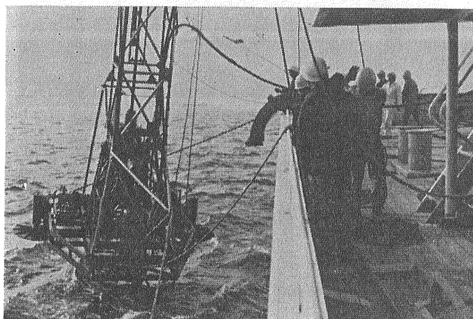
① 鉋研式マインドリルの海底の降下作業
