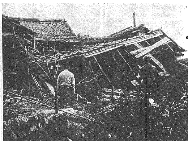
倒壊した土蔵 左の写真と同じ敷地内にあるが 内部の木材が白アリに食い荒されていたためにこの惨状となった
