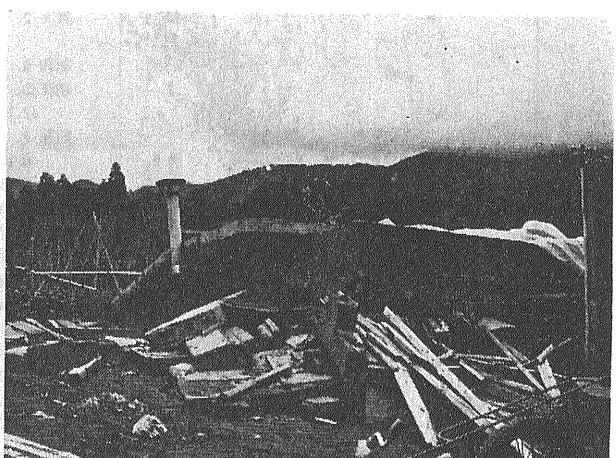
3月25日の地震によって倒壊した左の家屋
