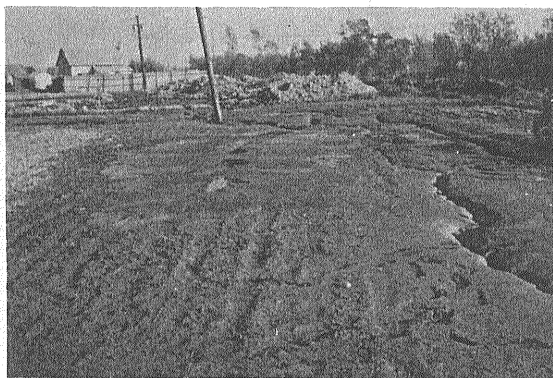
10 水田に生じた地割れと噴砂現象 電柱も傾いている 長沼町27区
