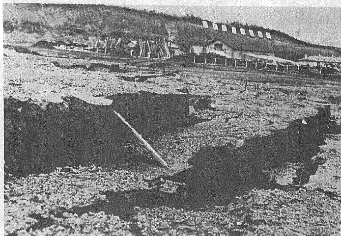
24 宅地造成地にみられる地割れ沈降現象 地質は軽石流堆積物(札幌市清里)
