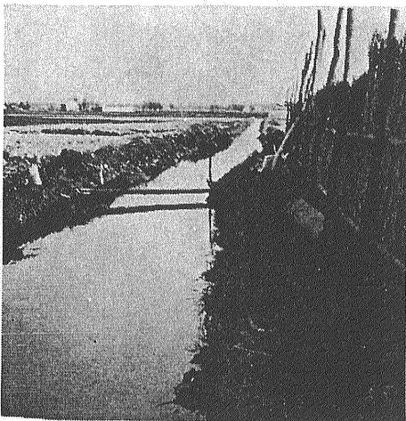
38 灌漑溝の横ずれ 長沼町27号
