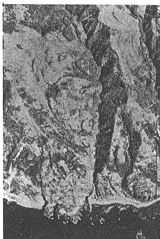
①豊浜地すべり空中写真 地すべり後 約1年 昭和38年9月8日撮影
