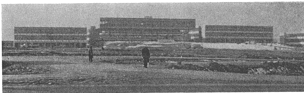
写真① 一部完成した M.T.A.新庁舎 中央は本館
