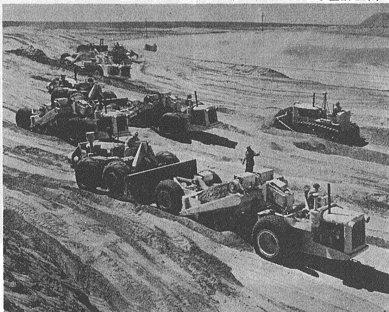
↑ 海岸に堆積した漂砂礫床をおおっている砂礫層の除去作業 (I.D.I.B. 提供)
