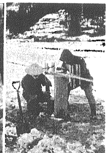
雪中においてインパール基線尺25mの中間測定
