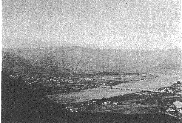
第V-7図 和歌山県那賀町付近を流れる紀ノ川 飯盛飯山付近
