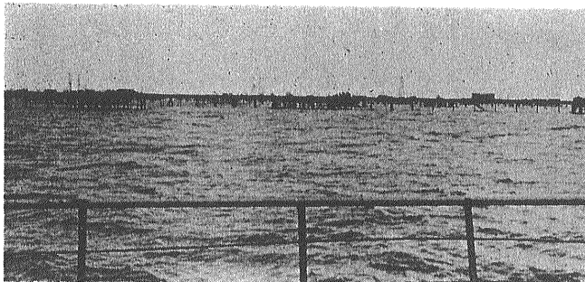
ネフチャニエ・カムニ海上油田 バクー市東方110km カスピ海の真中にあるパイプを海中に立て 街道 タンクなどを作りあげている。油田名は オイルストンの意味といわれる
