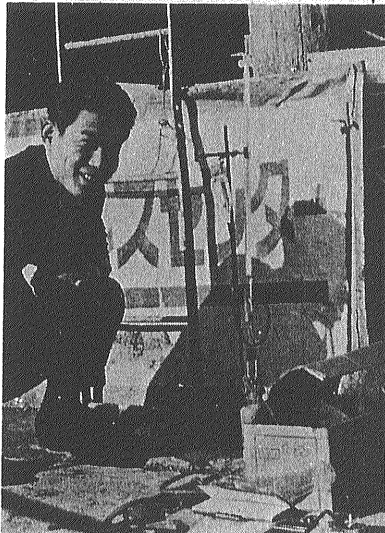
一 水中溶存ガスの分析(蟹江1号井) 水中溶存ガスの分析には 菅原式水中溶存ガス分析装置が広く使われている
