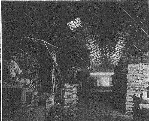
酸化チタン製品倉庫
