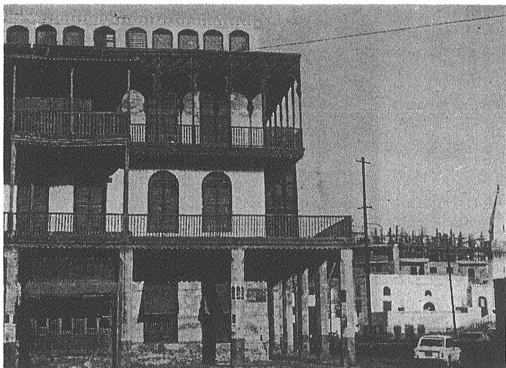
第38図 ジェッダ市の古い家 この家は旧市街に建つ古い家で ウスマントルコ時代のものともいわれている 大部分は珊瑚礁石灰岩のブロックからなり 床・天井・柱等に木材を使用している 電柱の右側の建物は現在建築中のコンクリート造りのビル 右端の白い塔は寺院の尖塔 (ミナレット) で右の方へ傾いており「ジェッダの斜塔」と呼ばれている
