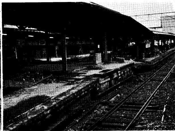
第2図 新潟駅プラットホームの被害状況(村下技官撮影)
