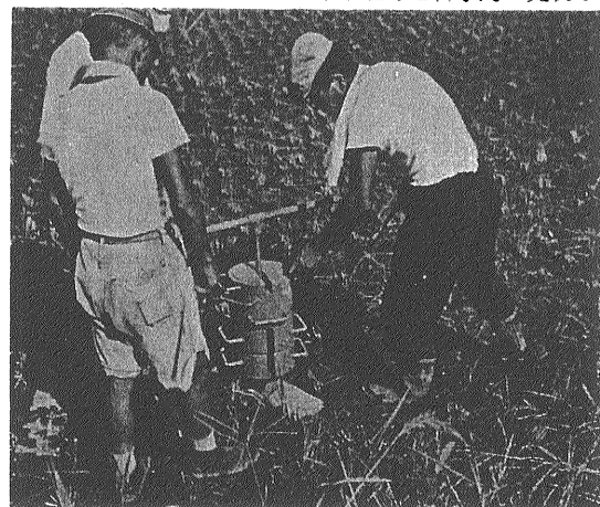
臨海工業地帯の地下構造調査（スウェーデン式サウンディング）
