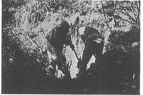
剝土作業 露出が悪いので地質調査にはとくに岩石の境界を確認するために剝土作業が行なわれる
