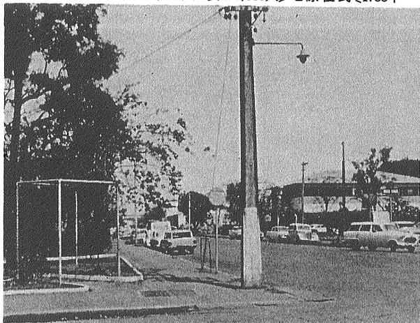
ダーウィン市内 電柱は木製だとアリが食べるのでレールを2本合わせて間にコンクリートを埋めて作ってある
