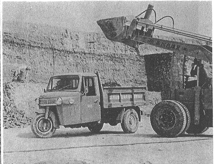
パワーショベルによる木節粘土の積込作業 (品川品野鋳山提供)
