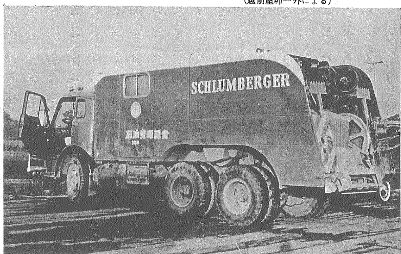
シュランベルジャー社の電気検層車(検層に要する一切の機械がこれに積み込まれている)
