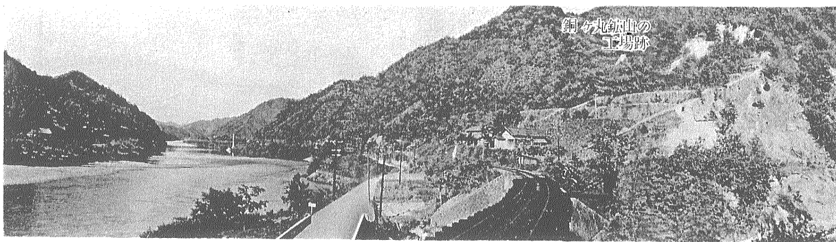
銅ヶ丸鉱山の工場跡 島根県邑智町今津にある 江川にのぞむインクライン跡の最高所から採掘場まで鉄道馬車が通じていた
