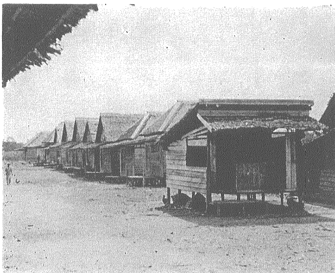
サラカマン部落の民家 雨期の出水のため床は上げている
