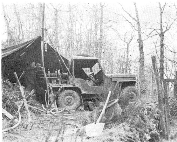
ブルジョー 地区でのボーリング (ワゴンドリル)
