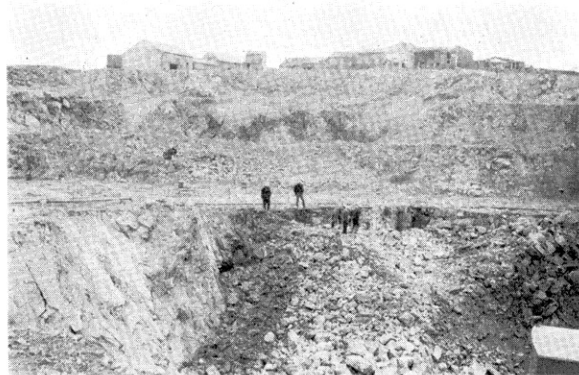
ブルジョー 鉱山の露天掘り
