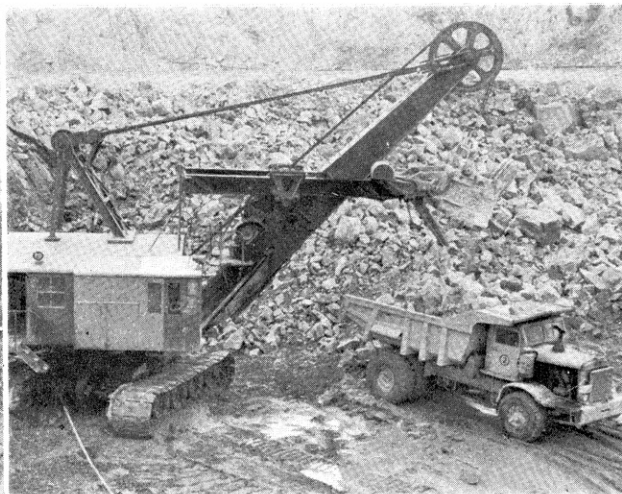
ブルジョー 鉱山露天掘り 積み込み場 パワーシベルとダンプカー (25t 積み)
