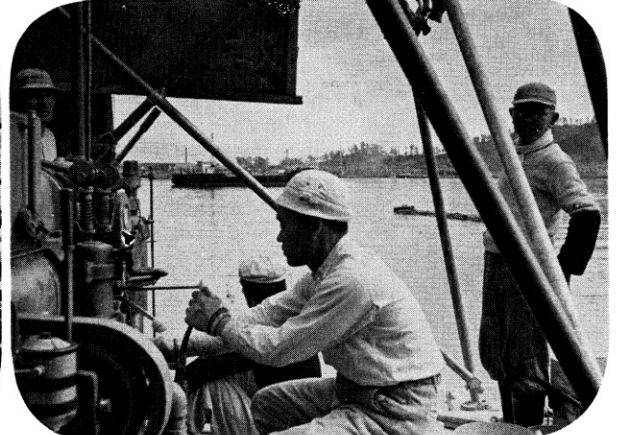
海上の温泉探査ボーリング
