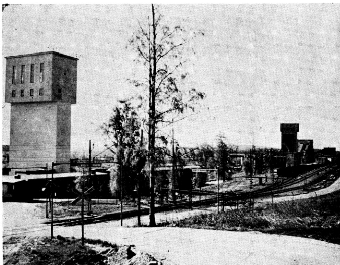
グレンゲスベリイ鉄山の中央立坑(左方)と南部立坑 白樺の美しい林の中に鉄山施設・事務所・社宅などが散在する
