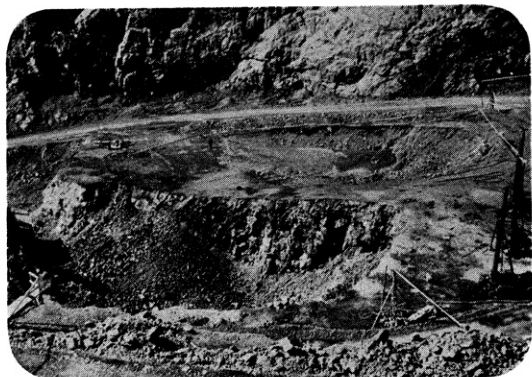
キイルナヴァーラ鉱床の露天掘の底部での採掘トラックドリルによるさく岩と積込用パワーシャベル
