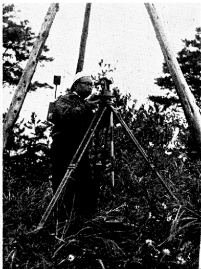
無線誘導による測線の設置
