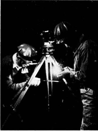
坑内の基線測量
