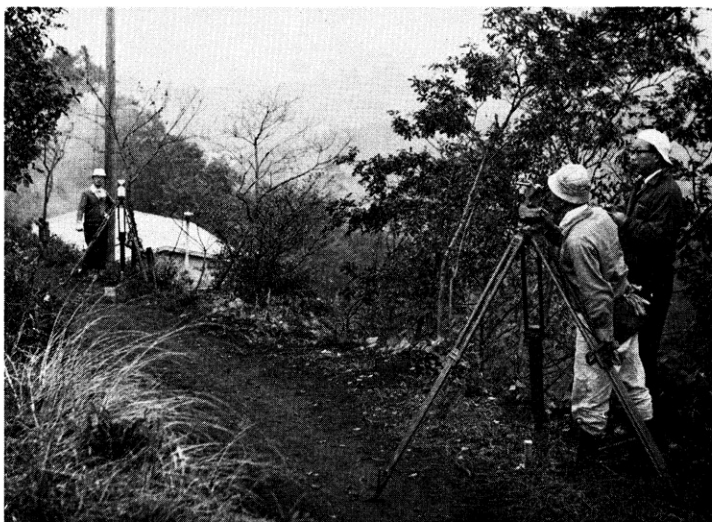
多角測量による図根点の設置
